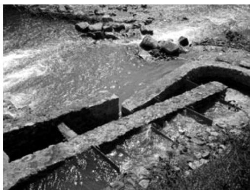
Scale di risalita per pesci, inserita nell'alveo per consentire la risalita dell'ostacolo rappresentato dalla traversa
